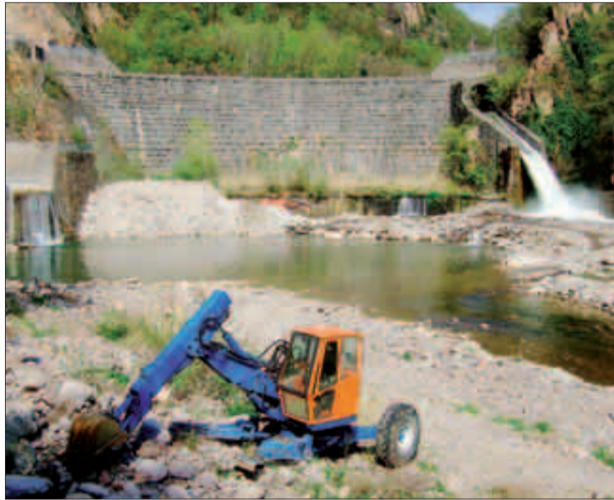
Zambel, la serra di San Giorgio. I lavori per la realizzazione della centrale idroelettrica
