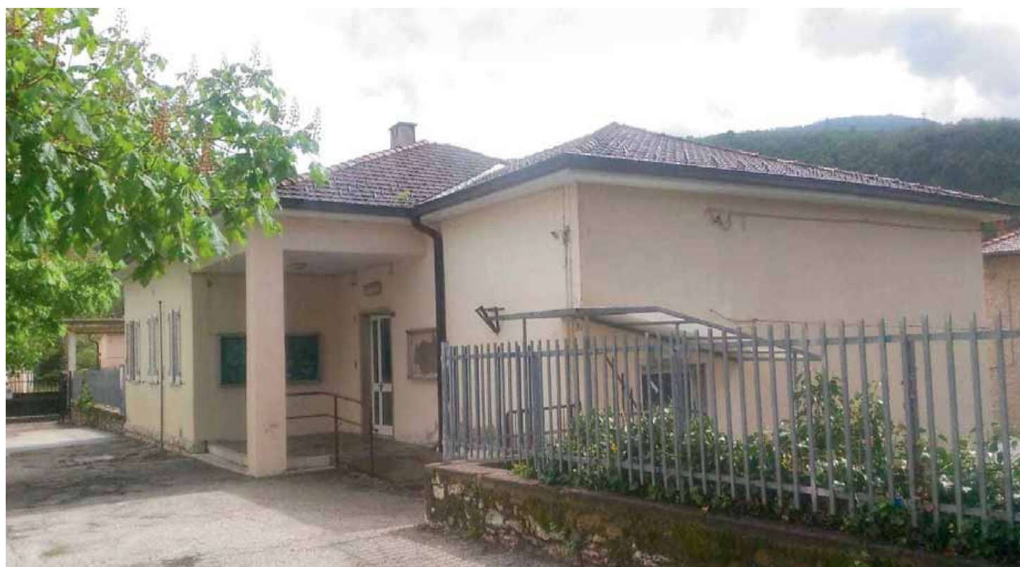
• L'ex scuola elementare di Cadine è chiusa dal 2010; da allora il Comune non è ancora intervenuto per dare alla struttura una nuova destinazione
